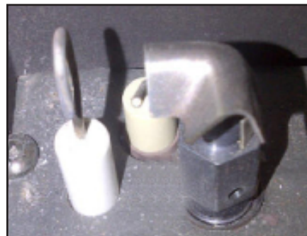
Figure 23: position correcte de la veilleuse
