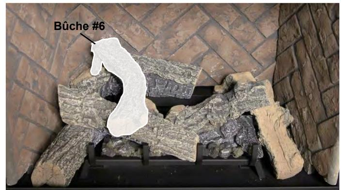
**Étape 7 :** Placez la **bûche #6** sur la bûche #1 et la bûche #5 en faisant attention de la positionner également entre les flammes du bout et du centre. Il ne doit pas y avoir de choc de flammes, cela pourrait faire de la suie.
