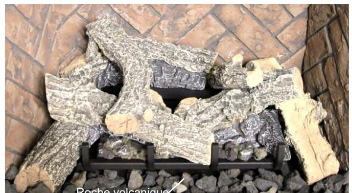
**Étape 9 :** Placez la roche volcanique sur le bas de la chambre de combustion.
