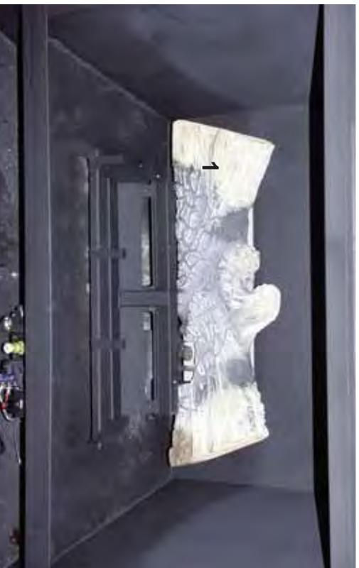
**Étape (1)** Placez la bûche arrière par dessus le support de bûche arrière et abaissez en place. Assurez-vous que la bûche n'est pas sur le brûleur arrière, mais derrière et plus bas que celui-ci.
